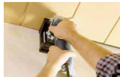
Обрязване краищата на дъсчена обшивка
